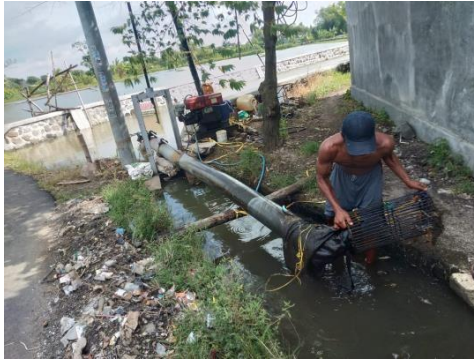
Gambar 3.1 Pemasangan Pompa di Titik Terendah
