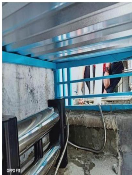
Gambar 2.3 Peralatan UV Sterilisasi Disambungkan Dengan Bak Tabung
