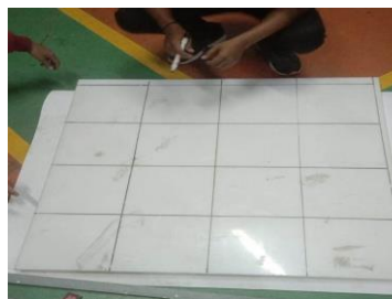
Gambar 2.4 Fabrikasi pengukuran dan pemotongan material LDPE
