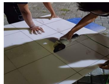
Gambar 2.4 Fabrikasi pengukuran dan pemotongan material LDPE
