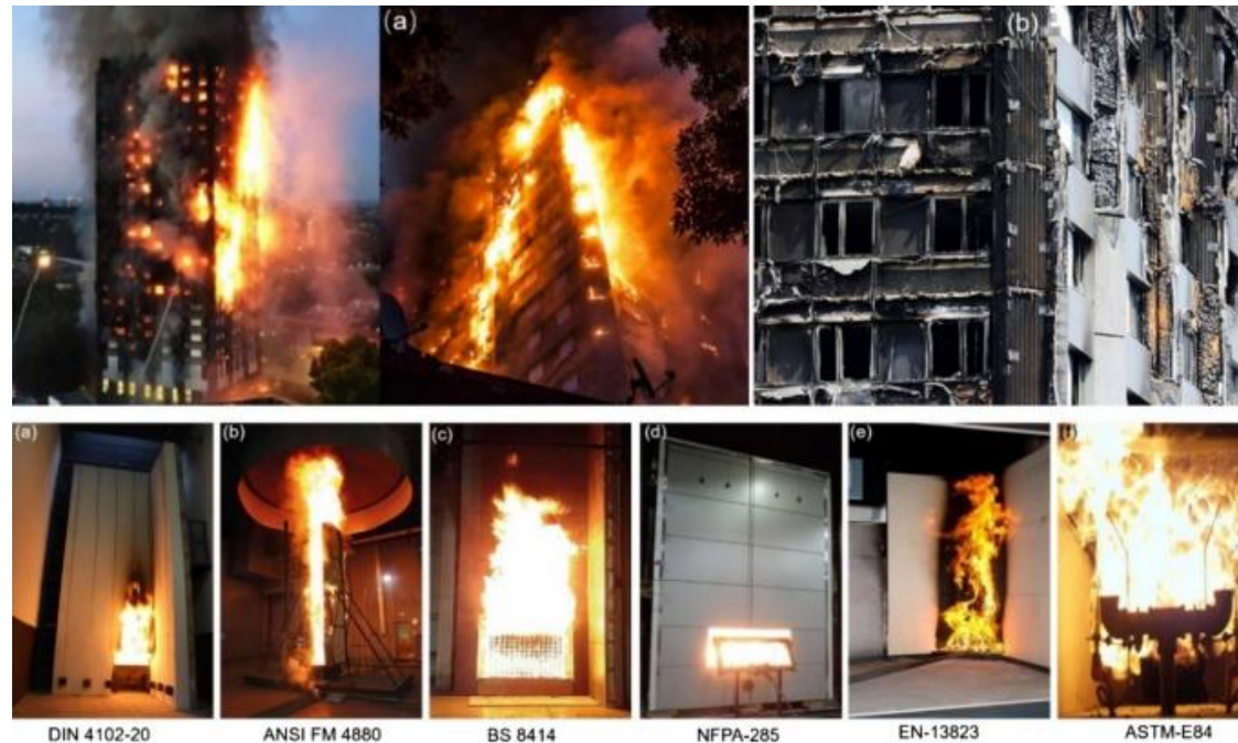
Gambar 1.3 Gedung yang terbakar menggunakan material ACP
