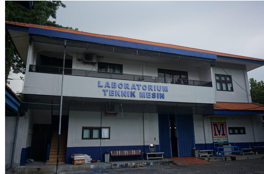
Gambar 2.1 laboratorium Teknik Mesin UMSIDA
