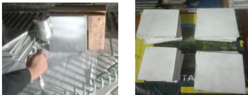
(A) (B) Gambar 8 (A) APC dilapisi lapisan cat tahan api ( fire-retardant coating/FRT ) menggunakan compressor (B) APC telah dilapisi cat tahan api
