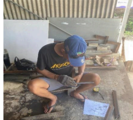
Gambar 5. Proses Pengukuran Besi Siku
