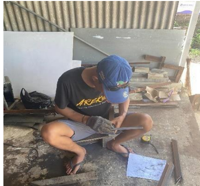
Gambar 5. Proses Pengukuran Besi Siku
