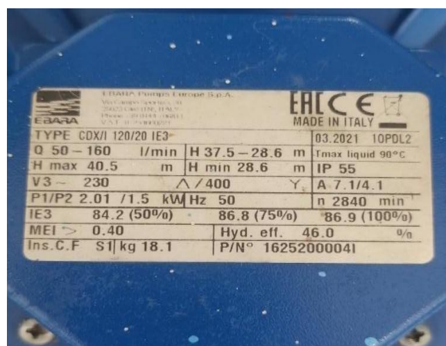
Gambar 4 Spesifikasi pompa centrifugal cdx/I
