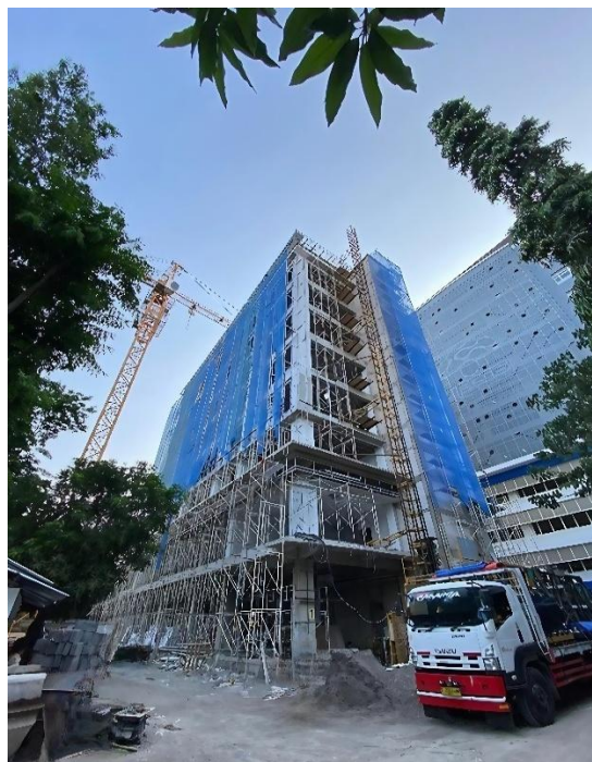
Gambar 3. Proyek pembangunan Gedung kuliah yang sedang berjalan
