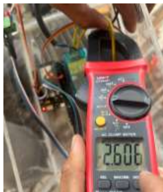
Gambar 9. Pengujian Arus Kompresor
