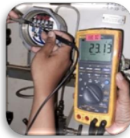
Gambar 9. Pengukuran Tegangan Pressure Switch
