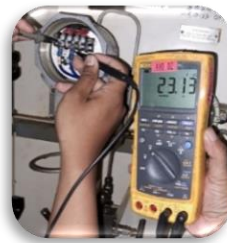
Gambar 9. Pengukuran Tegangan Pressure Switch
