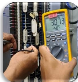
Gambar 11. Pengukuran Arus I/O Module dan Pressure Switch
