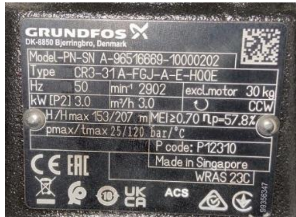
Gambar 4 Spesifikasi pompa Jockey tipe CR Vertical Multistage Pump
