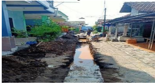
Gambar 1. Pembangunan Gorong-gorong di Desa Rangkah Kidul
