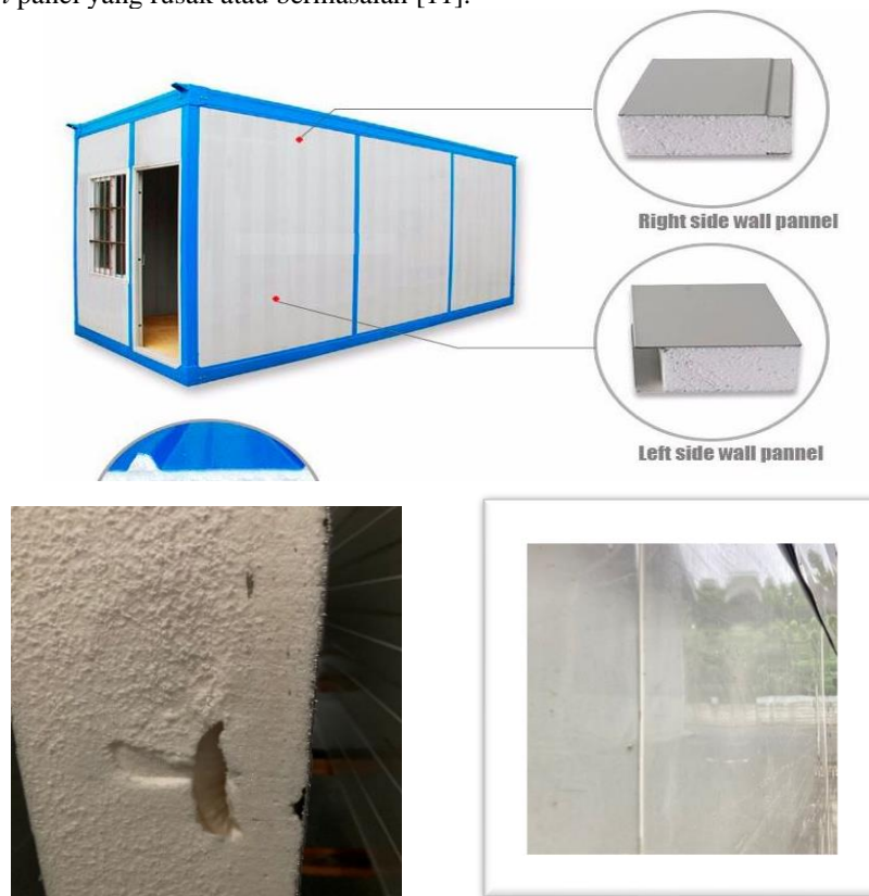
Gambar 1. Contoh Kerusakan Sandwich Panel
