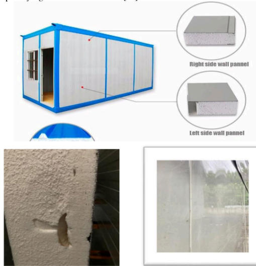
Gambar 1. Contoh Kerusakan Sandwich Panel
