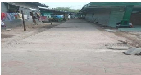
Gambar 2. Pavingisasi Di Dusun Juwet Selatan
