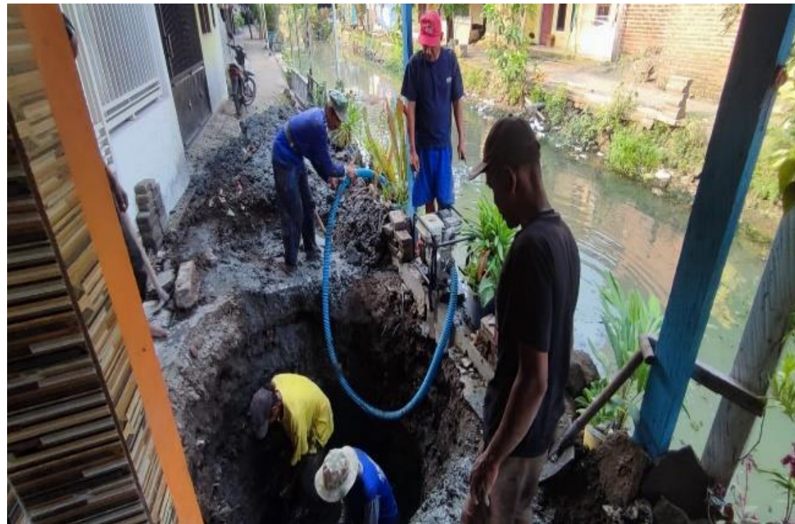
Gambar 3. Penggalian Saluran Sarana Sanitasi di Desa Larangan
