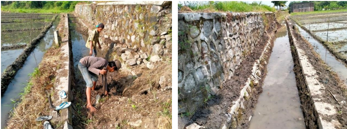
Gambar 1.7 Pembersihan Saluran Air di Daerah Persawahan dan Pembangunan Jaringan Sumber Daya Air di Desa Ketapang Untuk Menunjang Ketahanan Pangan
