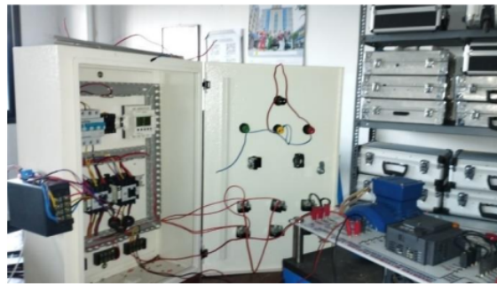
Gambar 6. Posisi pemasangan alat
