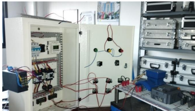
Gambar 6. Posisi pemasangan alat
