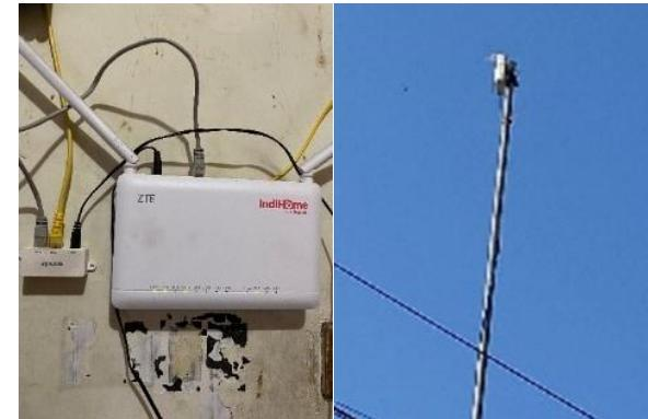
Gambar di atas adalah hasil jadi pemasangan modem ISP ke router pemanca (transmitter) di titik A, yang berfungsi sebagai sumber internet.. Konfigurasi ini memungkinkan sinyal internet dari modem ISP dapat diteruskan dengan baik ke perangkat lain melalui router, memastikan koneksi yang stabil dan optimal di area tersebut. Pemasangan router penerima (receiver) dititik B.
