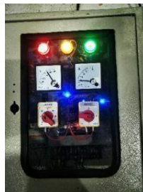
Gambar 3.1 Pengujian Tegangan R+S Dan Ampere R
