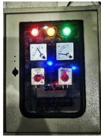
Gambar 3.2 Pengujian Tegangan S+T dan Ampere S
