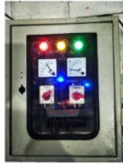
Gambar 13 Pembacaan Nilai Arus T pada Panel
