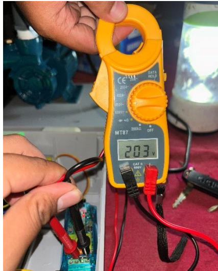
Gambar 3.1. Pengujian Tegangan Menggunakan AVO Meter
