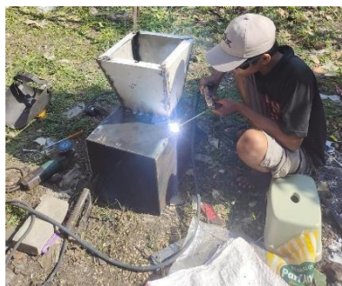
Gambar 2 perakitan ruang pres
