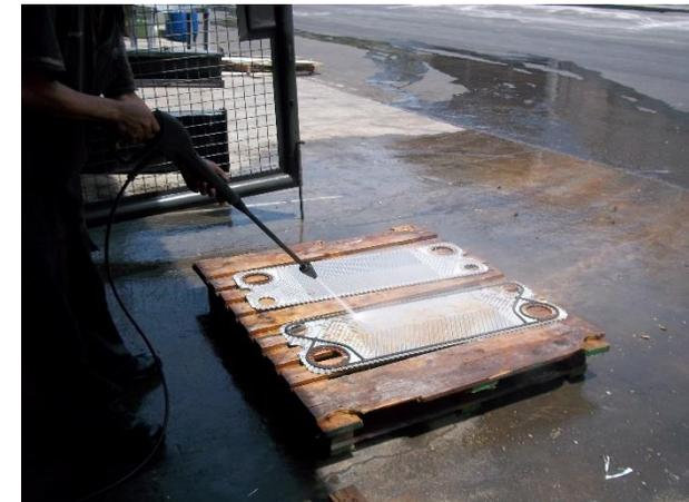
**Gambar.** Proses pembersihan *plat heat exchanger* sebelum menggunakan larutan asam
