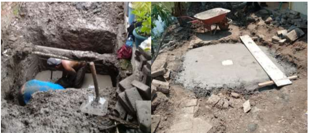
Gambar 4. Pembangunan Septic Tank Komunal di Desa Larangan
