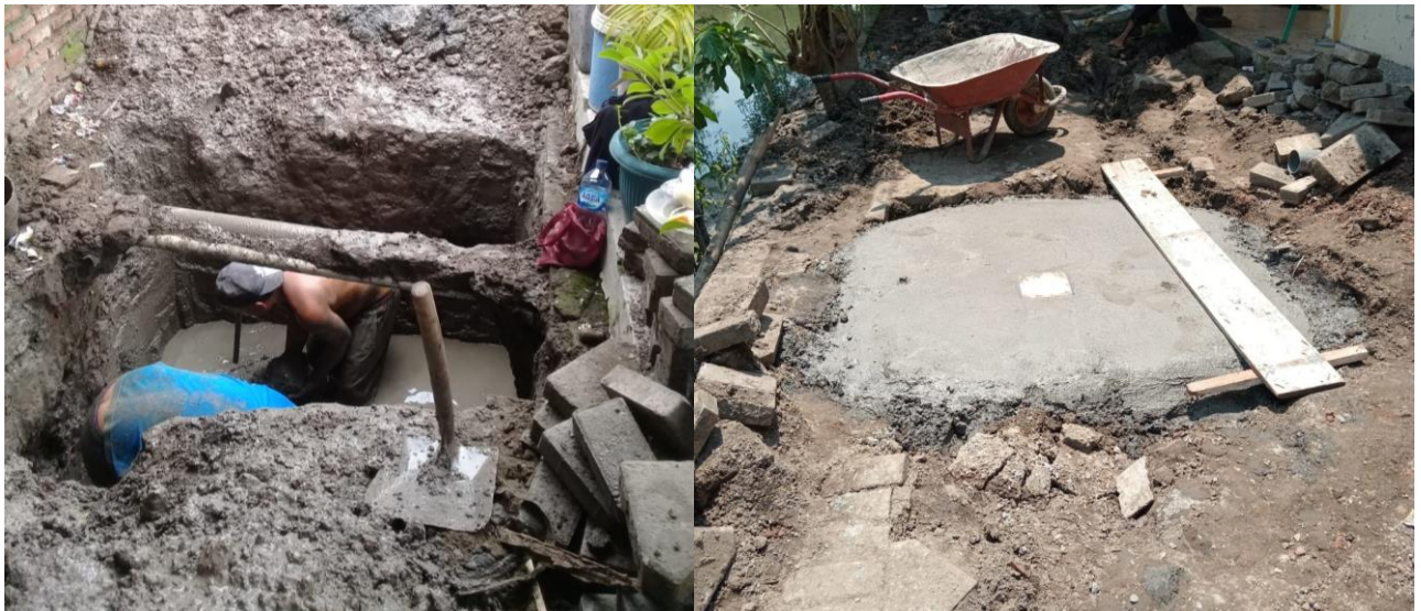
Gambar 4. Pembangunan Septic Tank Komunal di Desa Larangan
