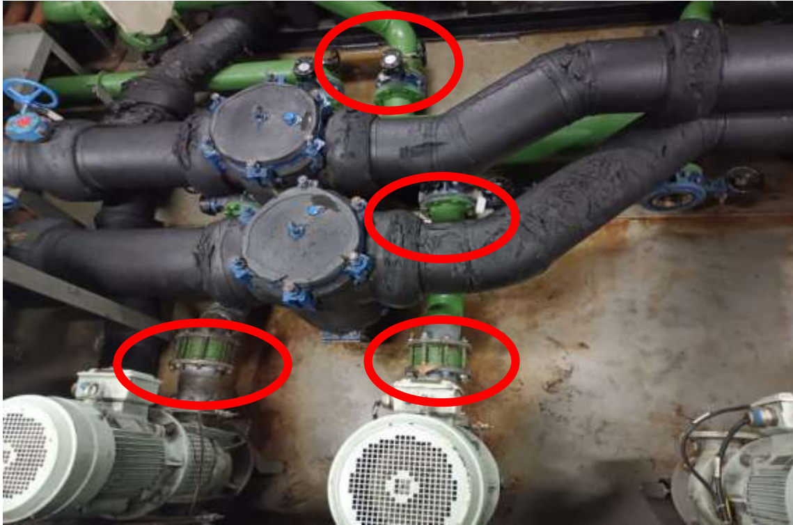
Instalasi pipa air laut untuk pendingin (fres water coolen)
