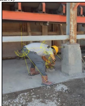
Gambar 2. Postur kerja aktivitas pekerja pada bagian variasi beton ready mix
