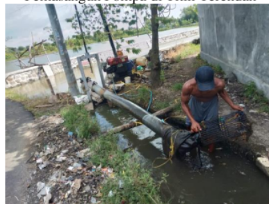
Gambar 3.1 Pemasangan Pompa di Titik Terendah
