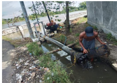
Gambar 3.1 Pemasangan Pompa di Titik Terendah
