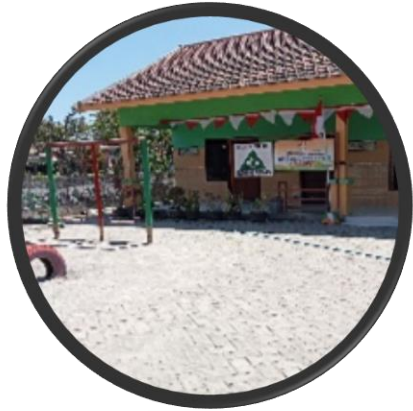
Pembangunan dan peninggian halaman TK Dharma wanita
