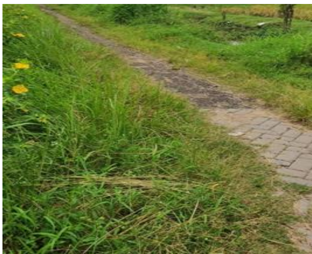
Gambar 2. Pembangunan Jalan Paving Di Pemukiman Sawah
