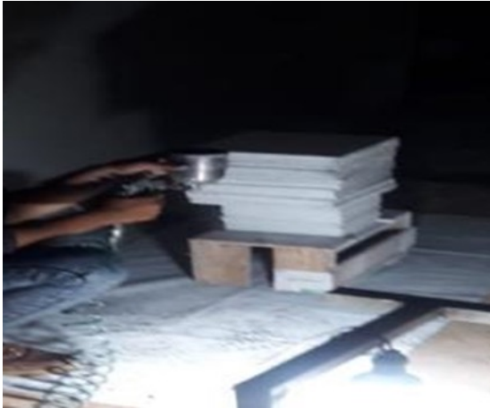
Gambar2.7 pelapisan dengan cat tahan api
