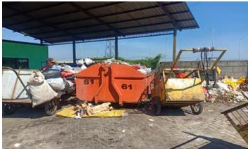
Gambar 1. Kondisi TPS3R Kalisampurno
