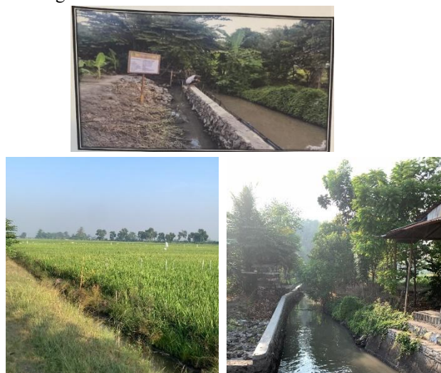
Gambar 3. Kondisi 50% dan hasil pembangunan
