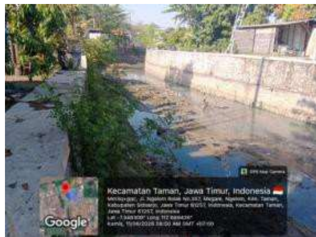
Sumber : Dinas Pekerjaan Umum Bina Marga dan Sumber Daya Air Kabupaten Sidoarjo, 2026
