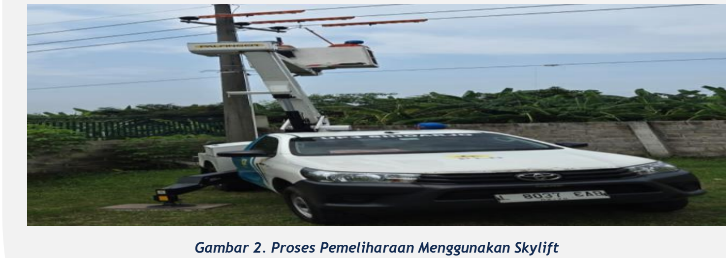
Gambar 2. Proses Pemeliharaan Menggunakan Skylift
