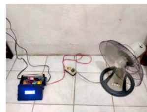
Gambar 12. Percobaan pada kipas
