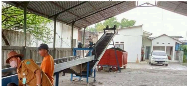
Gambar 2 : Kondisi atap TPST Kedungturi setelah revitalisasi :
