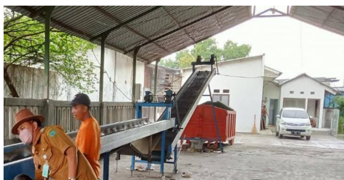
Gambar 2 : Kondisi atap TPST Kedungturi setelah revitalisasi :
