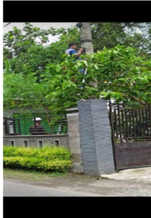
pemasangan WIFI ID
