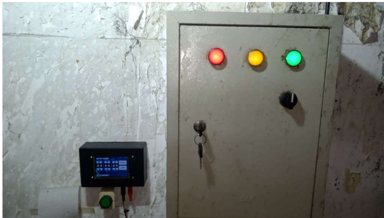
Gambar 6. Implementasi panel kontrol mixer alginate berbasis Arduino dan Nextion Display
