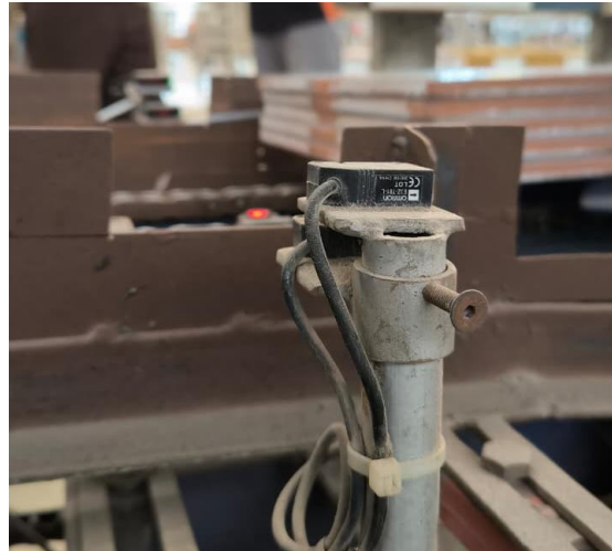
Gambar 6. Hasil Jadi Pemasangan Sensor
